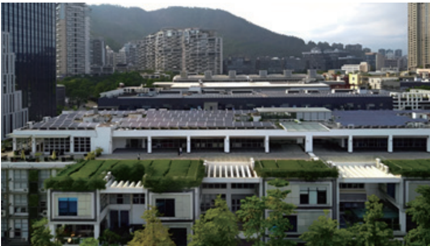
南海意库屋顶的太阳能光电板
