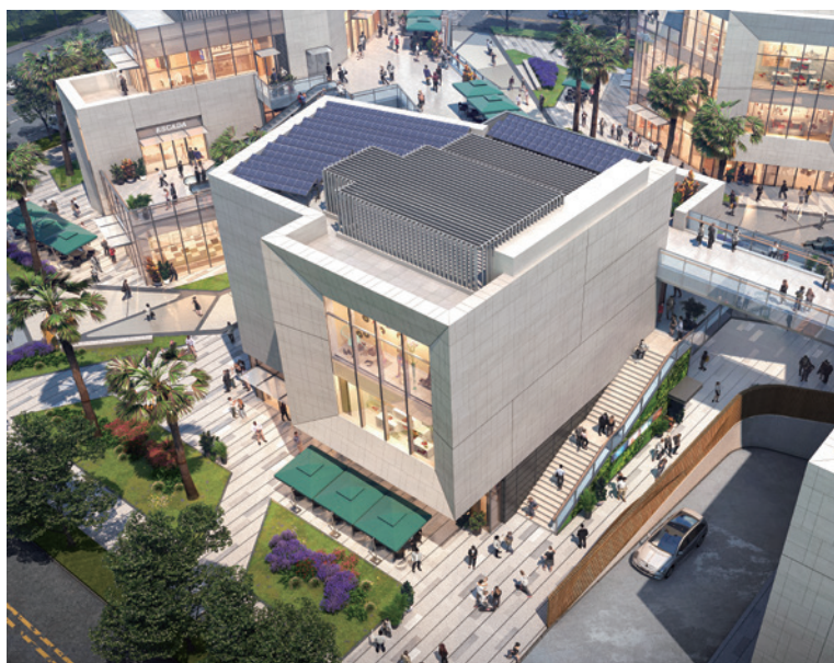
太子湾 04-05 地块听风阅海园四单元项目 - 近零能耗建筑
